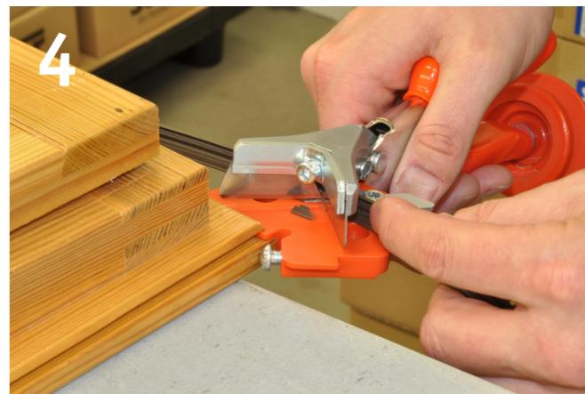
Schnitt durchführen und Dichtung ausklinken
