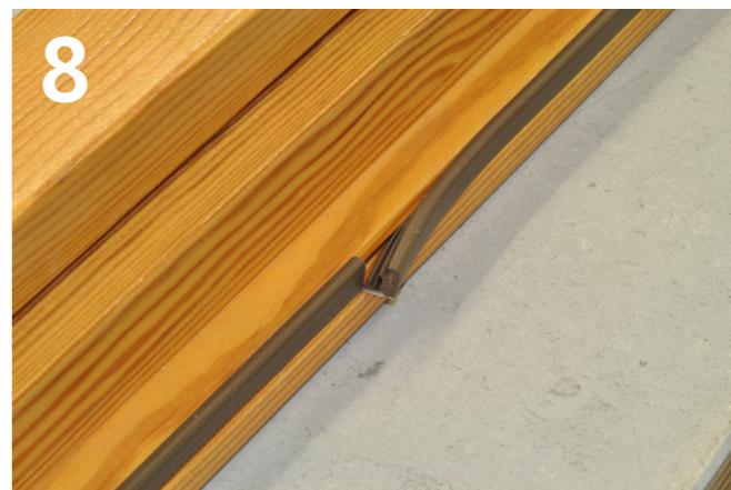
Die umlaufende Dichtung kann nun bündig abschließend eingezogen werden
