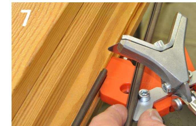
Anschlag wie abgebildet an den Anfang der Dichtung anlegen und Endschnitt durchführen
