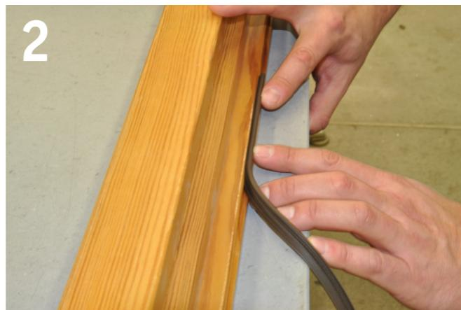
Dichtung bis zur ersten Ecke in die Nut einziehen oder einrollen
