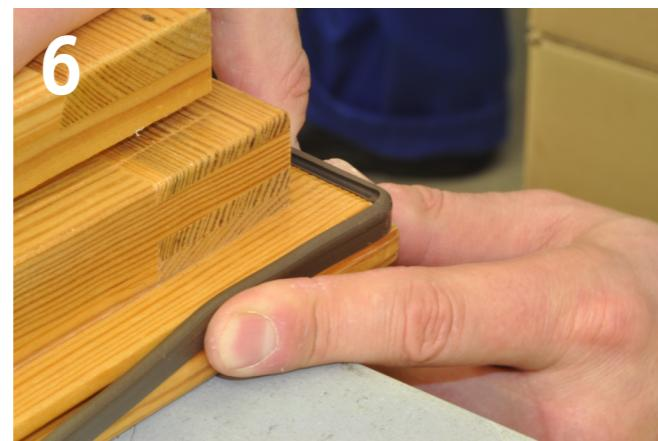
Dichtung um die Ecke legen und in die Nut einziehen; Schritt 2-6 für die anderen Ecken wiederholen
